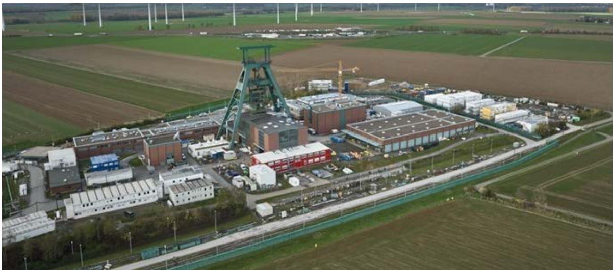
Abbildung 2: Luftbild des Endlagers Konrad, Betriebsgelände Konrad 1
