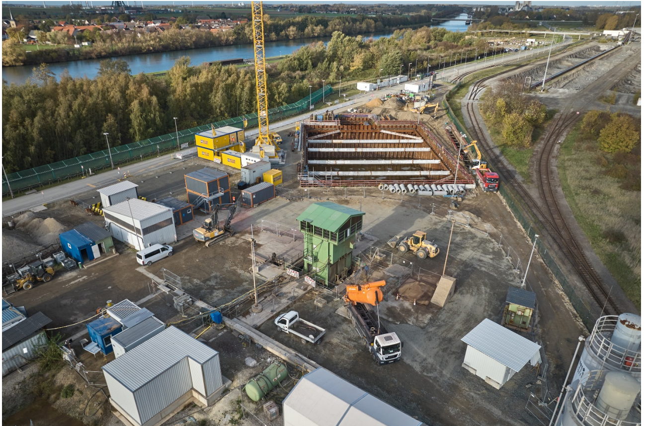
Abbildung 6: Luftbild des Endlagers Konrad, Betriebsgelände Konrad 2
