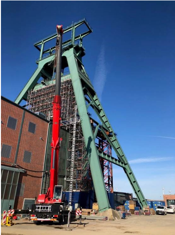
Abbildung 4: Schwerlastgerüst Ansicht Nordseite Konrad 1
